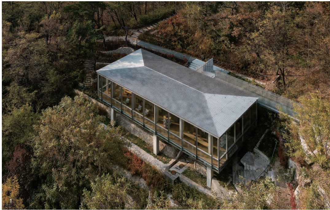
1 철근콘크리트 필로티 기둥 모듈의 2분의 1 간격으로 목재 기둥을 세우고 그 사이에 지붕판을 끼워 넣은 인왕산 숲속쉼터 (2021년 대한민국 목조건축대전 준공부문 대상).
